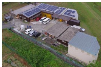
株式会社 MIXIM 本社工場
