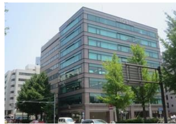
博多1091ビル（自社管理ビル）
