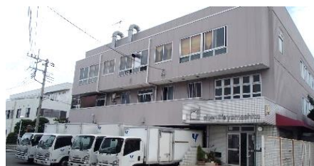
株式会社クリーンライフヤマシタ 第二工場
