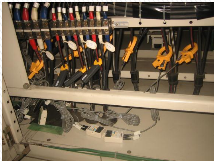
クランプ設置状況①
